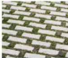
Pavage en béton avec ouvertures de drainage
