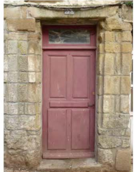
Rue du Château - Porte à planches dans un cadre
