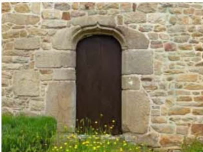
Linteau en « T » orné d'un arc en accolade, Kerléano
