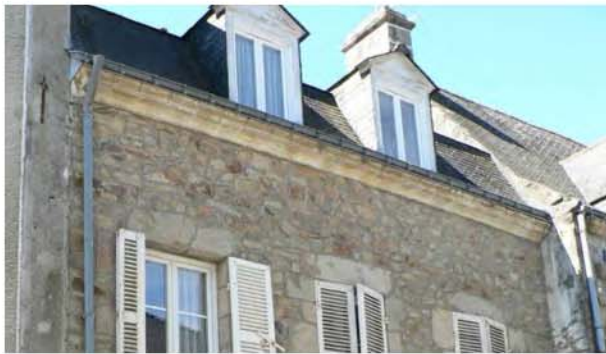
Corniche en pierre moulurée sous toiture (parfois en bois peint)
