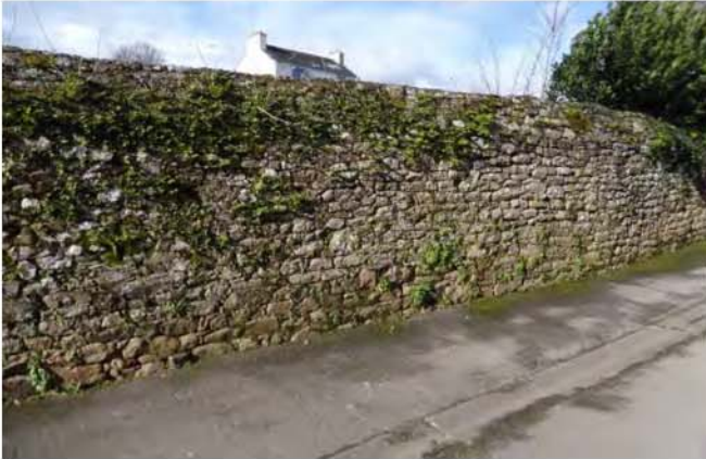
Mur plein, moellonné, toute hauteur (2,20 à 2,50 m)
