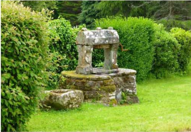
Kerléano. Puits à margelle circulaire et potence en pierre.
