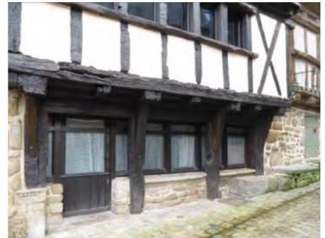
Lorsqu'une maison à pan de bois est construite sur poteaux en bois, la devanture doit être positionnée entre ces poteaux ou légèrement en retrait.
