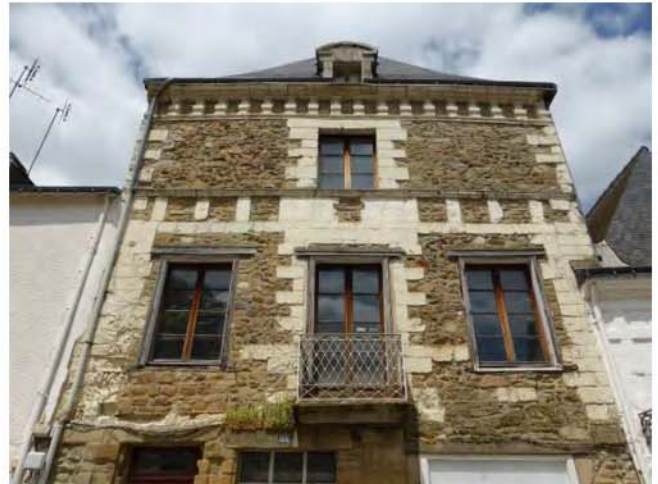
Pierre calcaire (tuffeau) de couleur blanche. Le moellonnage en granite était destiné à être enduit. Maison rue du Château.
