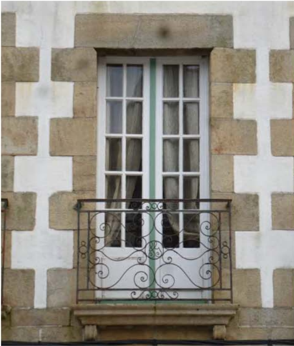
Balcon en ferronnerie avenue du Maréchal Joffre
