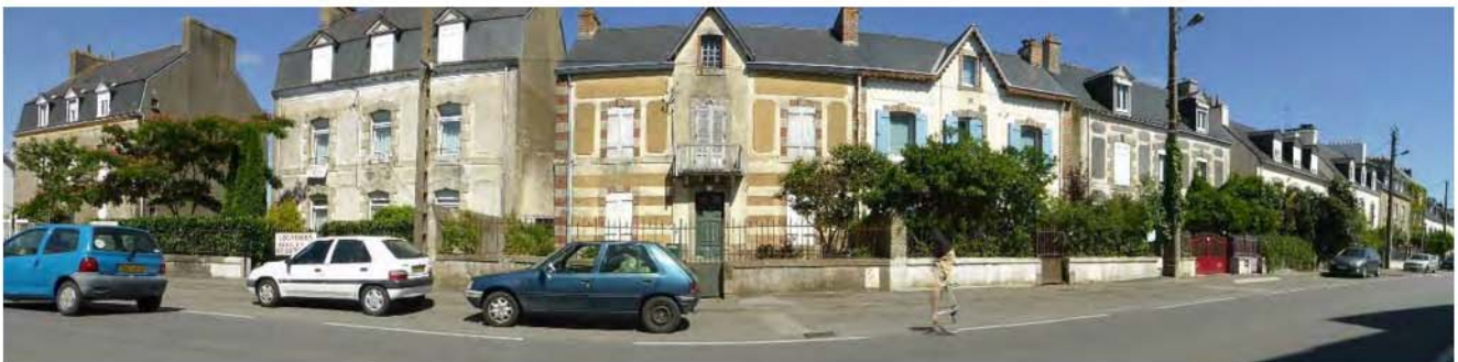
Avenue du Général de Gaulle : la cohérence résulte de la répétition de la largeur parcellaire, du niveau d'égout de toiture, de la rythmique des baies (compositions tripartites) et de la continuité de clôture sur un modèle unique.
