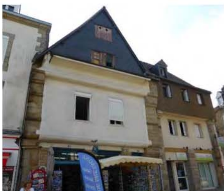
58 et 56, rue du Château (Mpb)
