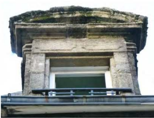
Lucarne à fronton curviligne en granite. Maison rue du Château.
