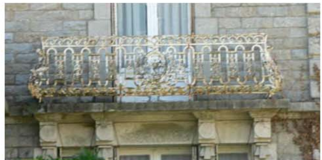
Balcon en fonte
