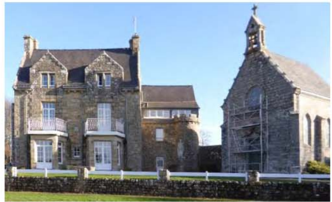
Manoir de Kerplouz. Appareil de granite apparent
