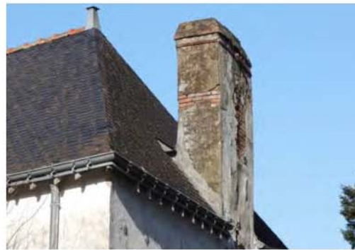
Chevrons apparents et sous face bois peint (forget)
