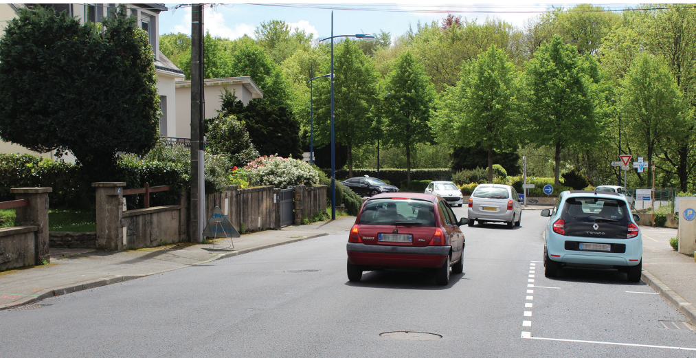
La rue de la Libération réouverte à la circulation après les travaux.
