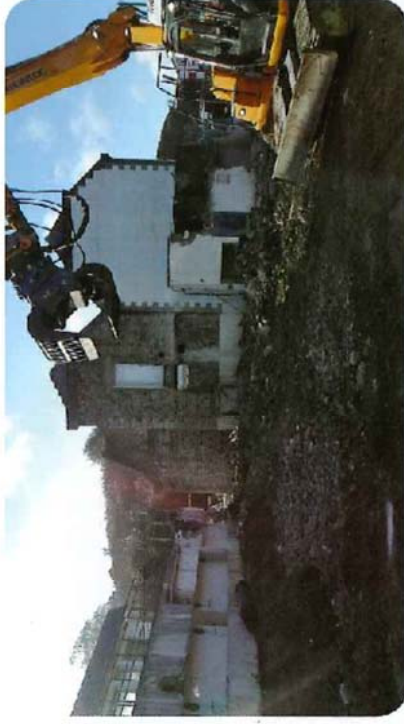
Démolition Bordilla LE PALAIS
