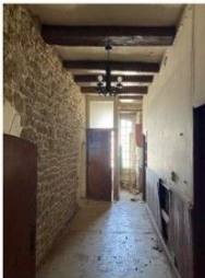
Circulation en bon état
