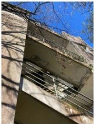
Escalier béton et ascenseur extérieur
