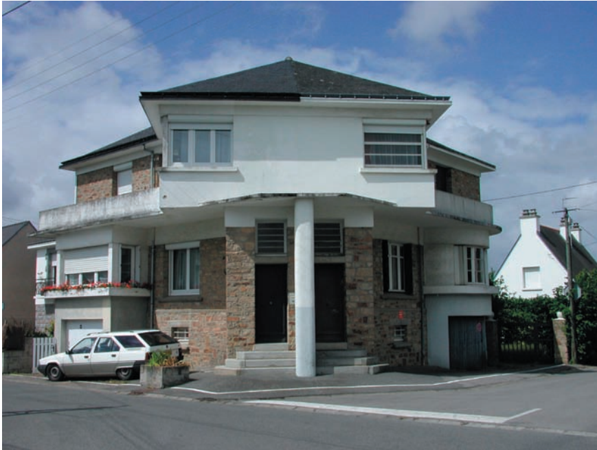
Maison, 6 rue Sombreuil – 9, rue Cadoudal
