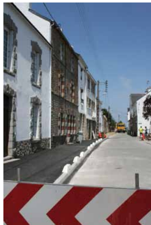
La rue du Penher en cours de réaménagement.
