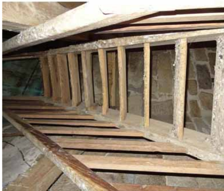
La dernière voûte dépasse le niveau du plancher du dôme et va jusqu'à la base de la toiture métallique. Le rôle du solivage situé au-dessus du plancher n'a pas pu être étudié compte-tenu de la dangerosité de l'accès. S'agit-il d'un calage rapporté sous les tirants métalliques ?
