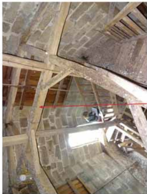
palier depuis le balcon et enrayure, support du plancher provisoire.
