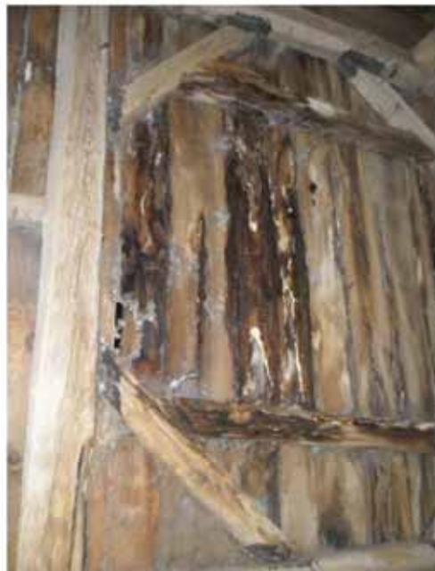
Plancher du niveau du dôme très dégradé
