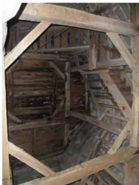
Échafauds menant au plancher du niveau du dôme
