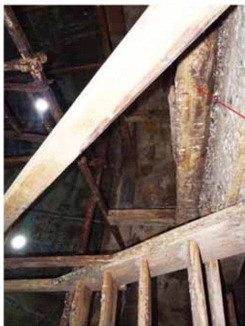
La dernière voûte dépasse le niveau du plancher du dôme et va jusqu'à la base de la toiture métallique. Le rôle du solivage situé au-dessus du plancher n'a pas pu être étudié compte-tenu de la dangerosité de l'accès. S'agit-il d'un calage rapporté sous les tirants métalliques ?
