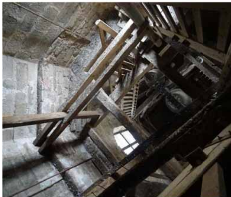
charpente en bois avec enrayures successives
