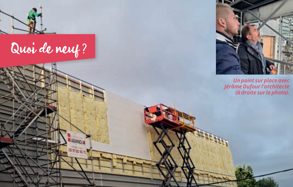
La pose du bardage en cours.
