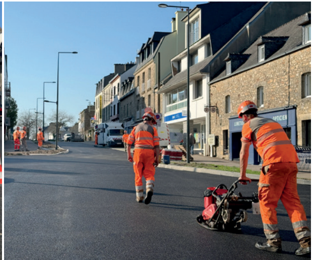
Les travaux d'enrobé de la Dorsale cyclable en cours de finition le 4 mars dernier.
