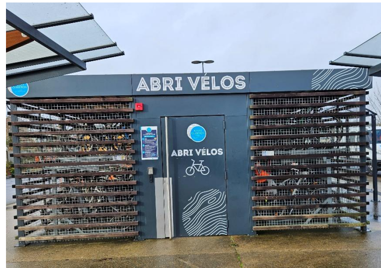
En gare : saturation de l'abri vélo et ses arceaux
