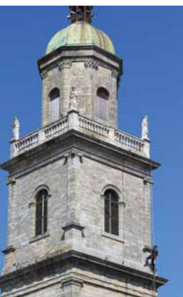
Des travaux en 2019 à l'église Saint-Gildas
