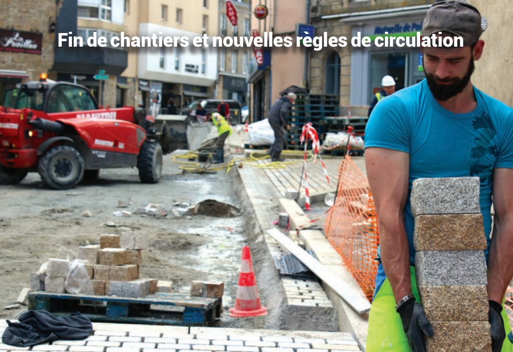
Centre-ville, les derniers pavés ont été posés avenue Wilson.
