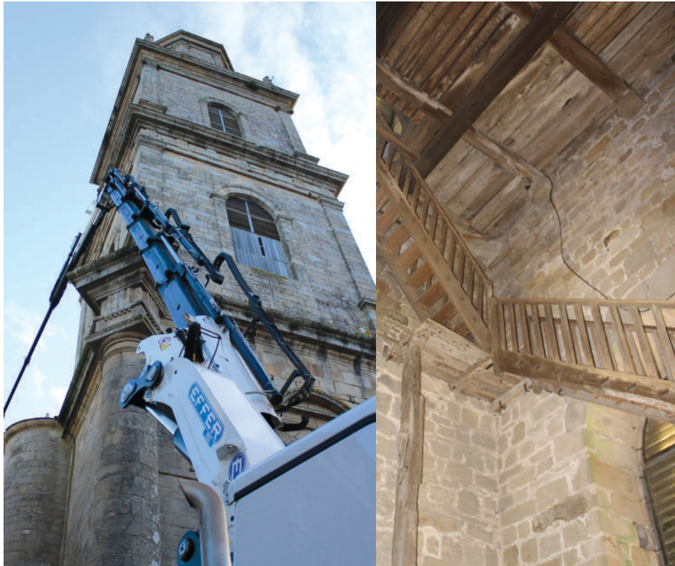
Le bois nécessaire à la réfection de l'escalier du clocher a été hissé à 30 mètres de haut.
